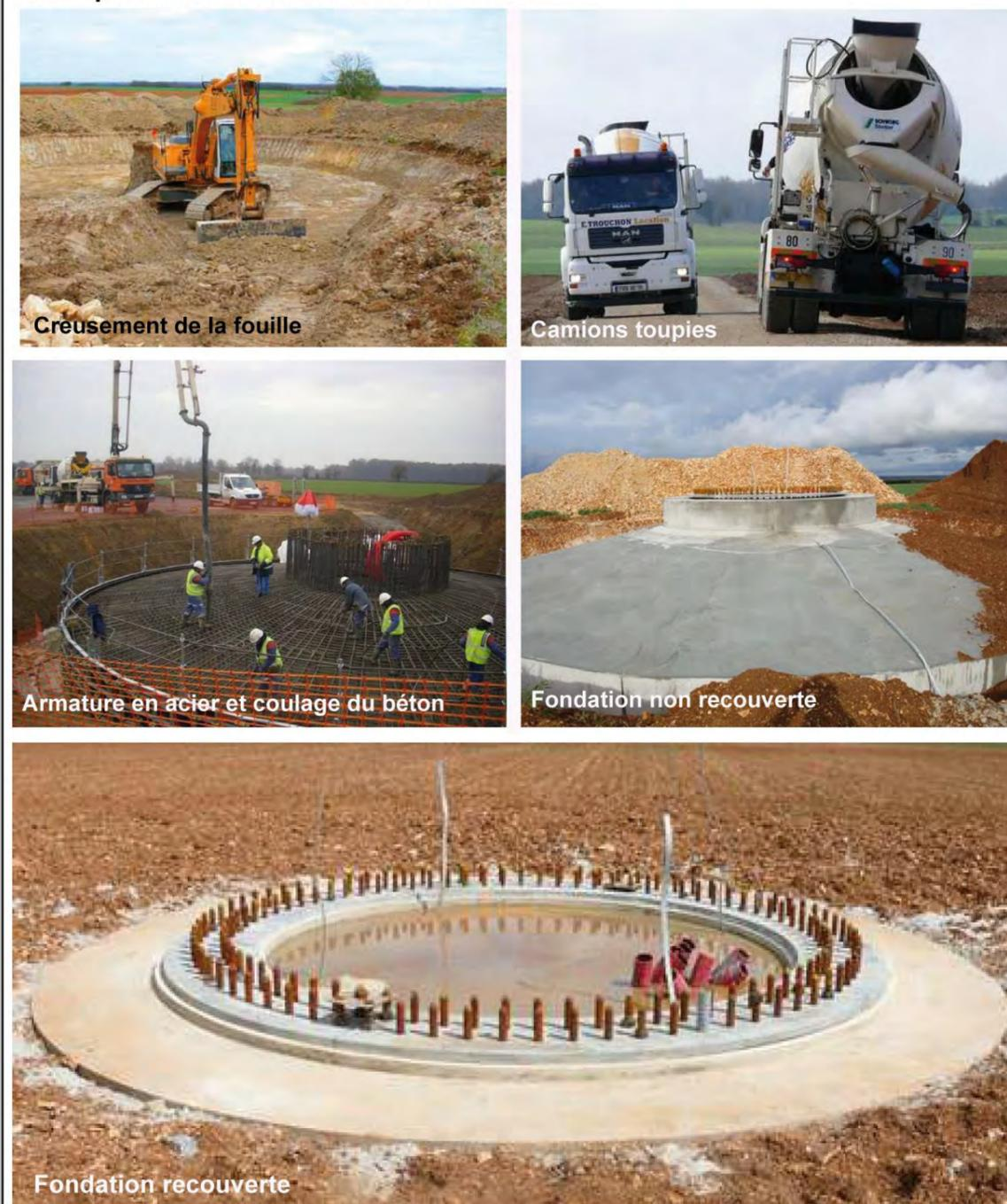
Photographie 3 : Étapes de réalisation d'une fondation d'éolienne
