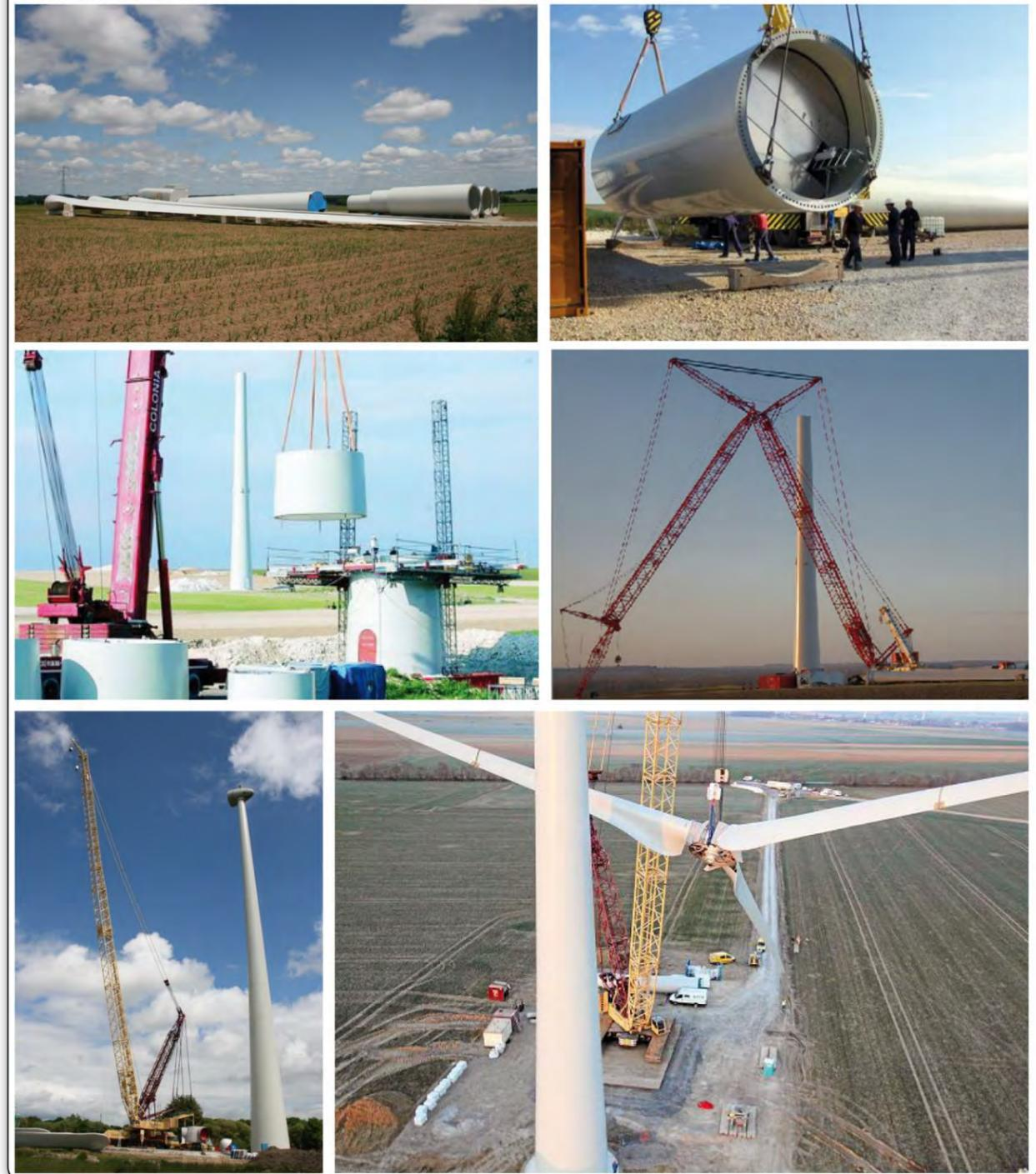
Photographie 5 : Phases d'assemblage d'une éolienne
