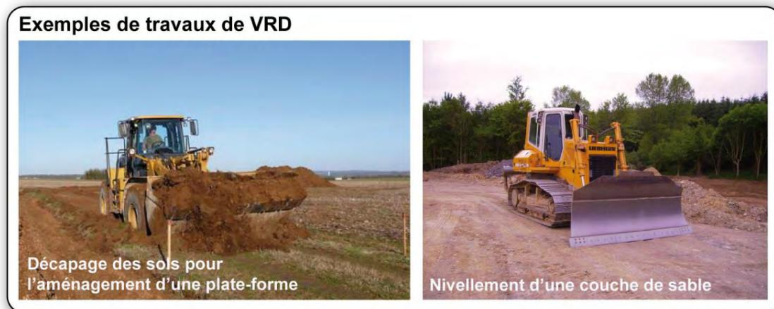
Photographie 2 : Exemples d'engins de travaux de VRD
