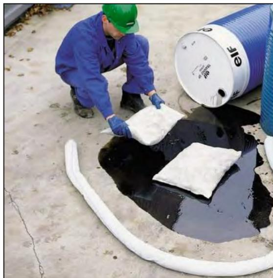
Photographie 13 : Kit anti-pollution utilisé sur une fuite d'hydrocarbures (Source : HALECO)
